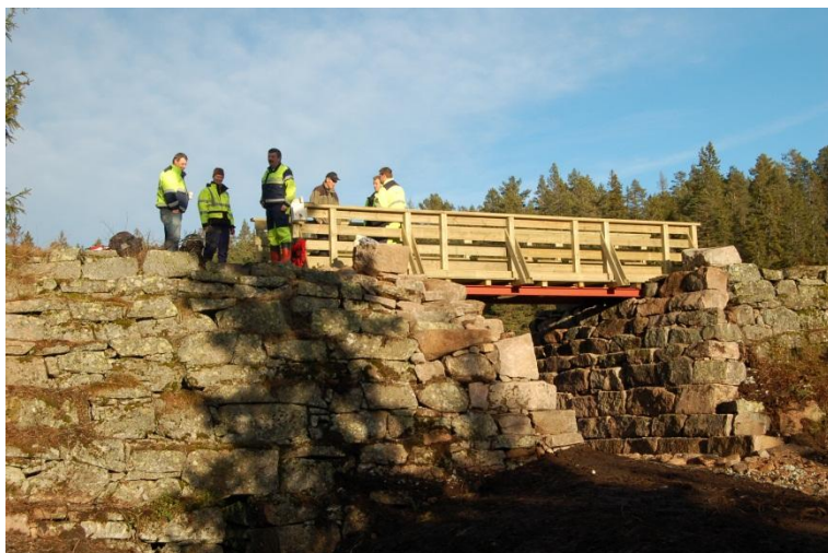
Bilde 5. Sidevangene i elveløpet er murt opp av stein fra den gamle dammen i Vivelstad som ble revet i 2009.
