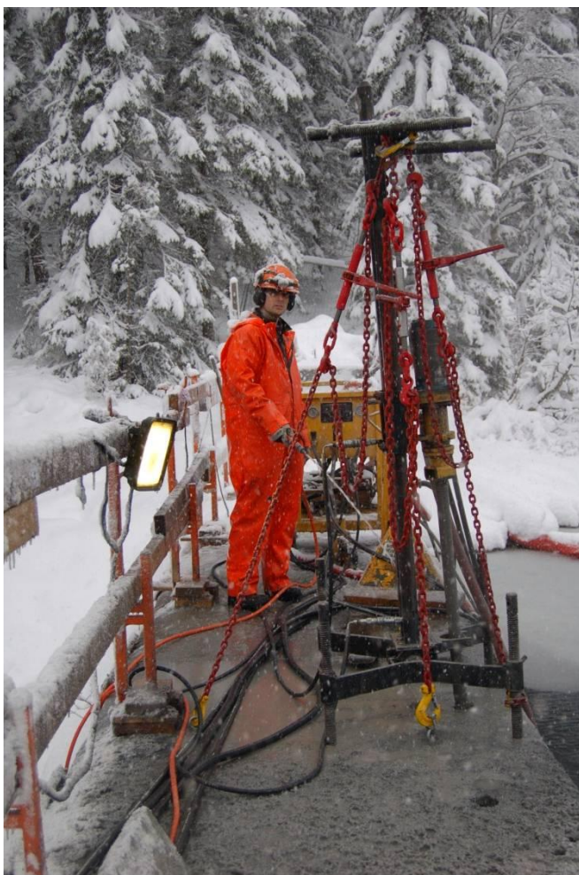
Bilde 7 Kald sørlending borer i fjell gjennom dammen.
