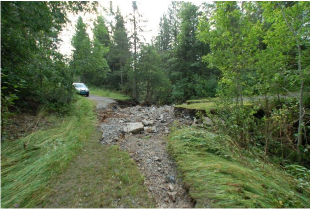
Bilde 1 Skader adkomst veg Bremsa
