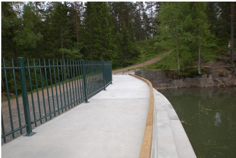
Bilde 4. Adkomst fra gangstien som går opp til parkeringsplassen vest for magasinet
